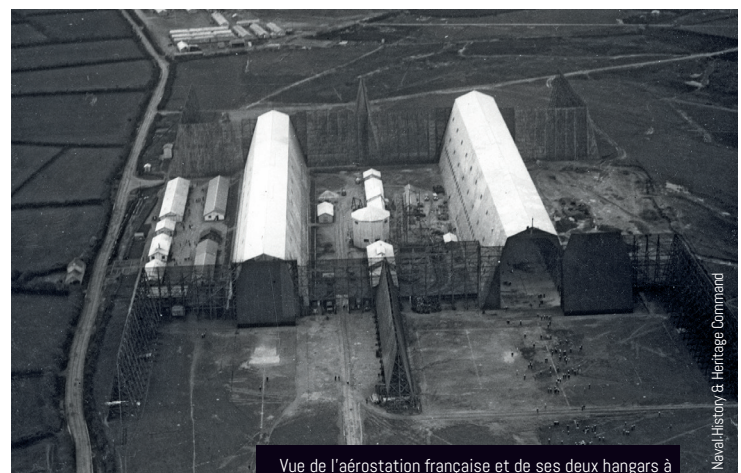
Vue de l'aérostation française et de ses deux hangars à dirigeables sur le site de l'actuel aéroport en 1918
